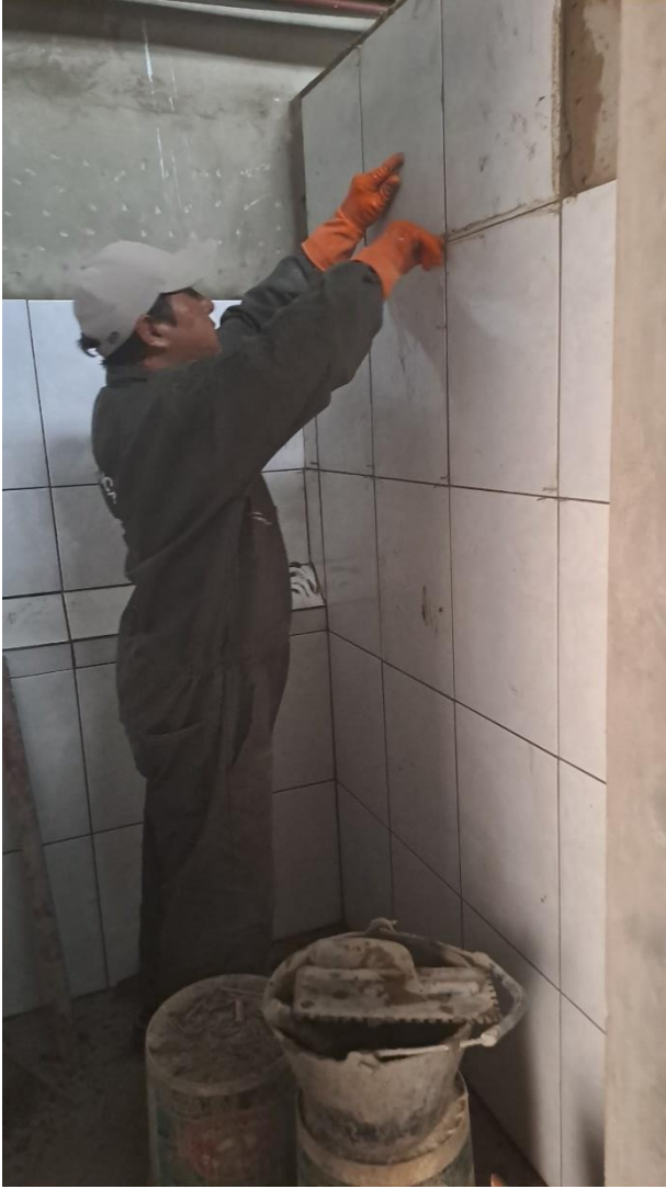
Fliesenarbeiten in den Duschen
