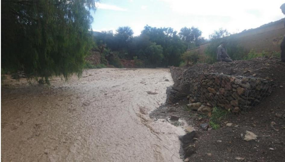
In der Regenzeit führt der Fluss an der Südost-Seite der Schule viel Wasser, weshalb mit einer Konstruktion von Gabionen bzw. Mauern aus Stein die Kraft des Wasser abgeschwächt werden soll.
