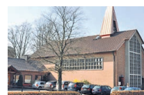
Das Dach der Heilig Herz Jesu-Kirche ist jetzt repariert
