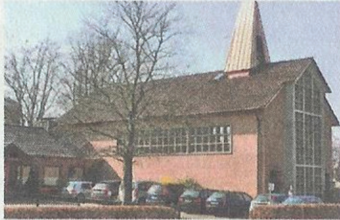
Das Dach der Heilig Herz Jesu-Kirche ist jetzt repariert
